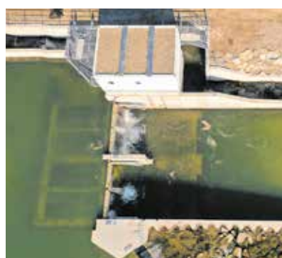
Anfang 2020 ging das Schachtkraftwerk in Großweil in Betrieb.
