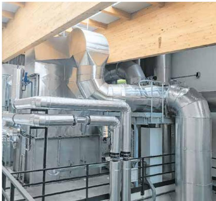
Mittels Rauchgaskondensationsanlagen spart der Betreiber nicht nur Geld, sondern reduziert auch den CO<sub>2</sub>-Ausstoß.
