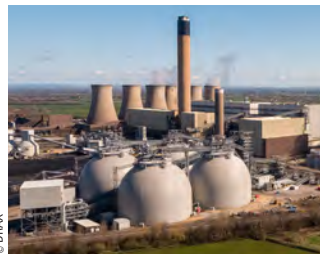
Das Pelletskraftwerk Drax ist das größte seiner Art in Europa.
