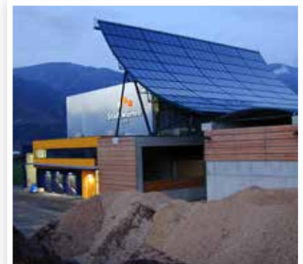
Biomasse-Fernheizkraftwerk Lienz – ein EU-Demonstrationsprojekt
