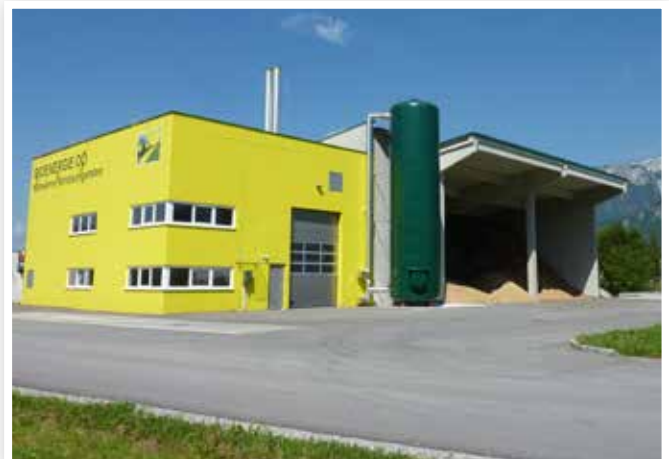
Heizwerk Windischgarsten – eines von 387 Biomasse-Heizwerken, die zahlreiche Gemeinden in Oberösterreich mit Wärme versorgen.
