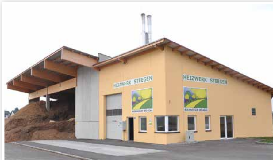
Seit 2012 versorgt dieses Biomasseheizwerk sämtliche Gebäude des Instituts „Caritas für Menschen mit Behinderungen St. Pius“ in Steegen mit erneuerbarer Wärme.
