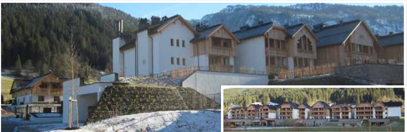
Das im Dezember 2016 eröffnete Leading Family Hotel & Resort Dachsteinkönig in Gosau wird per Wärme-Contracting von einer 1.000-kW-Pelletsanlage versorgt.
