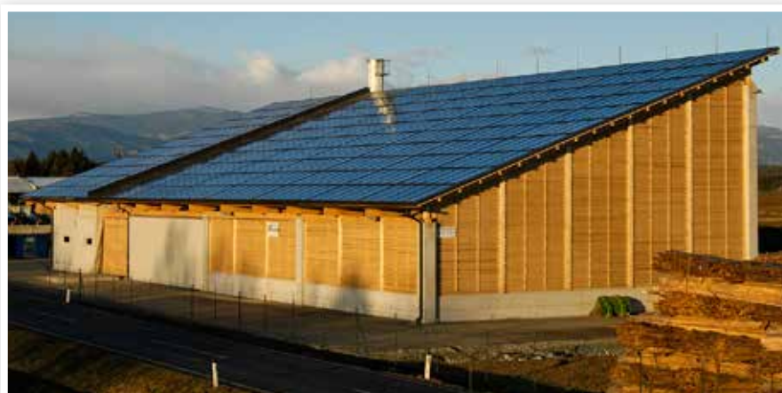
Thermische Solaranlage Gleinstätten
