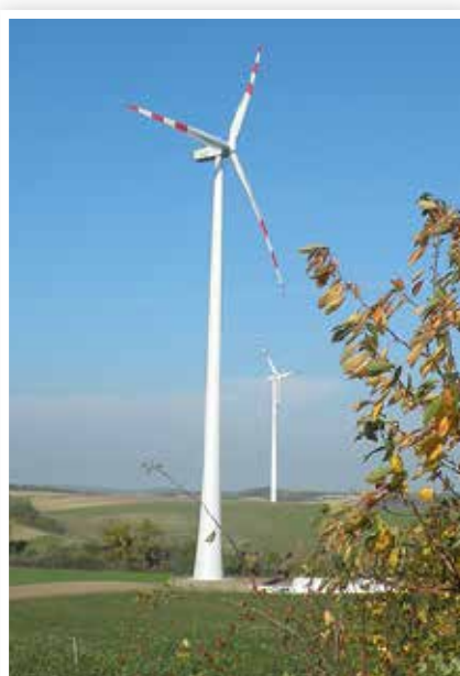
Windpark Poysdorf: Niederösterreich ist das Bundesland mit der größten Windkraftproduktion.
